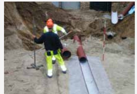
Tilslutningsrør udført som halveret rør.
