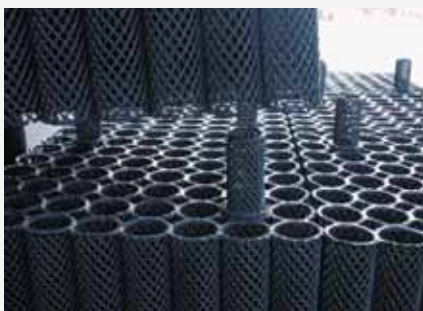
Montering af stabellere
