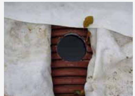
Tilslutningsrør udført med borede huller.
