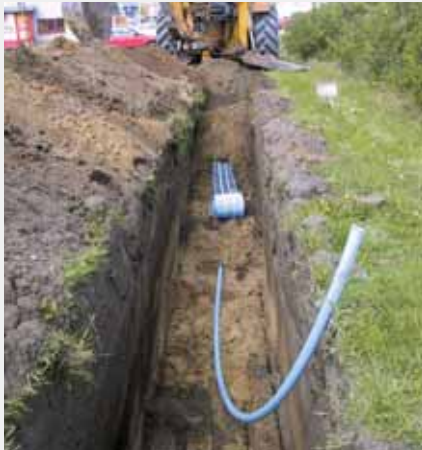
Udlægning af rør og advarselsnet
