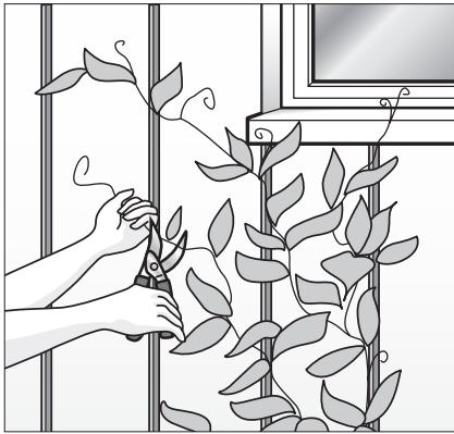
Fjern mos-, plante- og algevækst fra facadebeklædningen.
